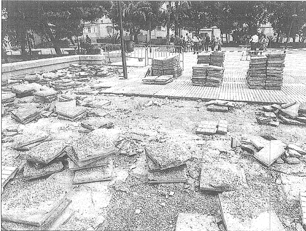
ARREGLOS. Una de las plazas del Polígono del Valle, en 2013, cuando el Ayuntamiento realizó obras.
